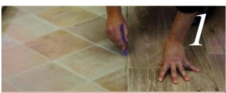
Coloque un adhesivo de doble cara no migrante o cinta adhesiva bajo la junta antes del doble corte.
